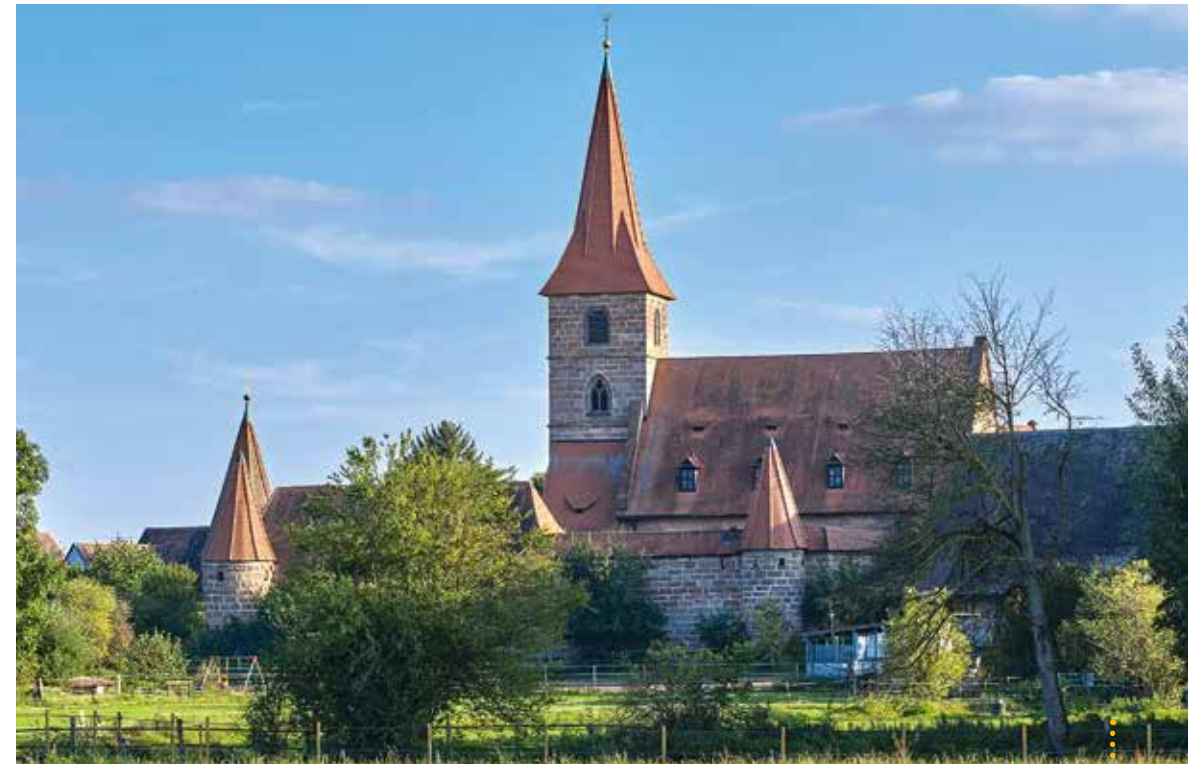
Fünf Türmchen mit spitzen Dächern verstärken die Mauer um die Wehrkirche von Kraftshof. Sie hielt allen Belagerungen stand.
